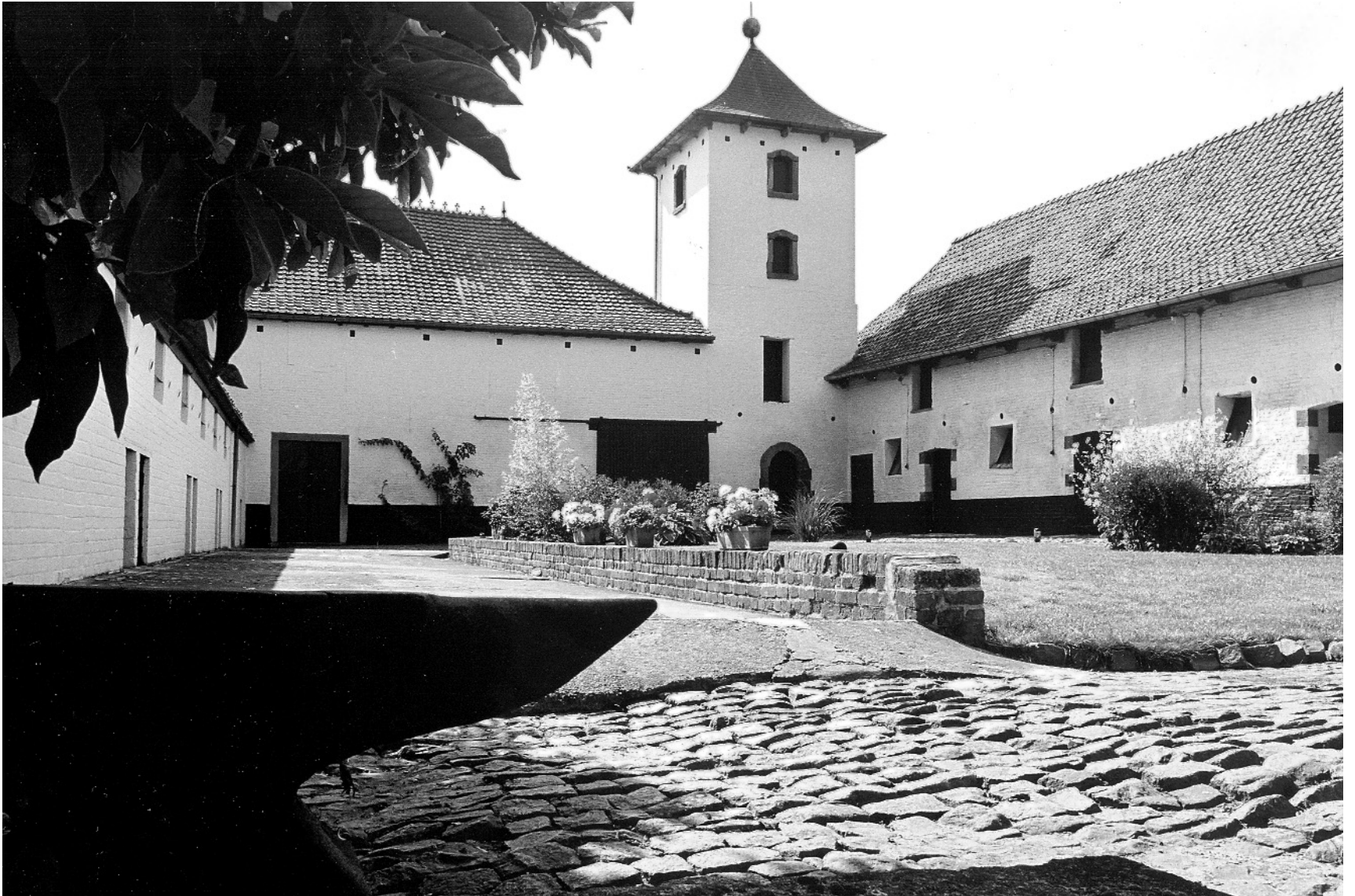
Sur le site du Château de Wisbecq
